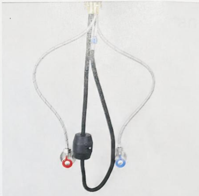
Hoàn tất lắp đặt
