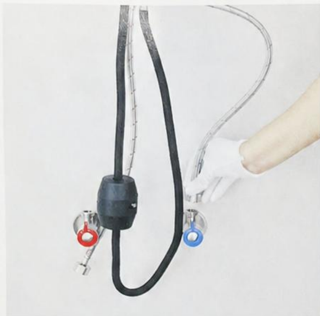
9. Kết nối van đường nước
